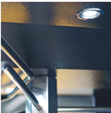
DECKENLEUCHE – automatischer Beleuchtungsmodus - Tag/Nacht, beleuchtet den Durchgangraum
